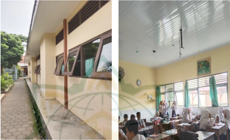
Gambar 4. 14 Ventilasi Jendela Ruang Kelas untuk Sirkulasi Udara dan Sinar Matahari
